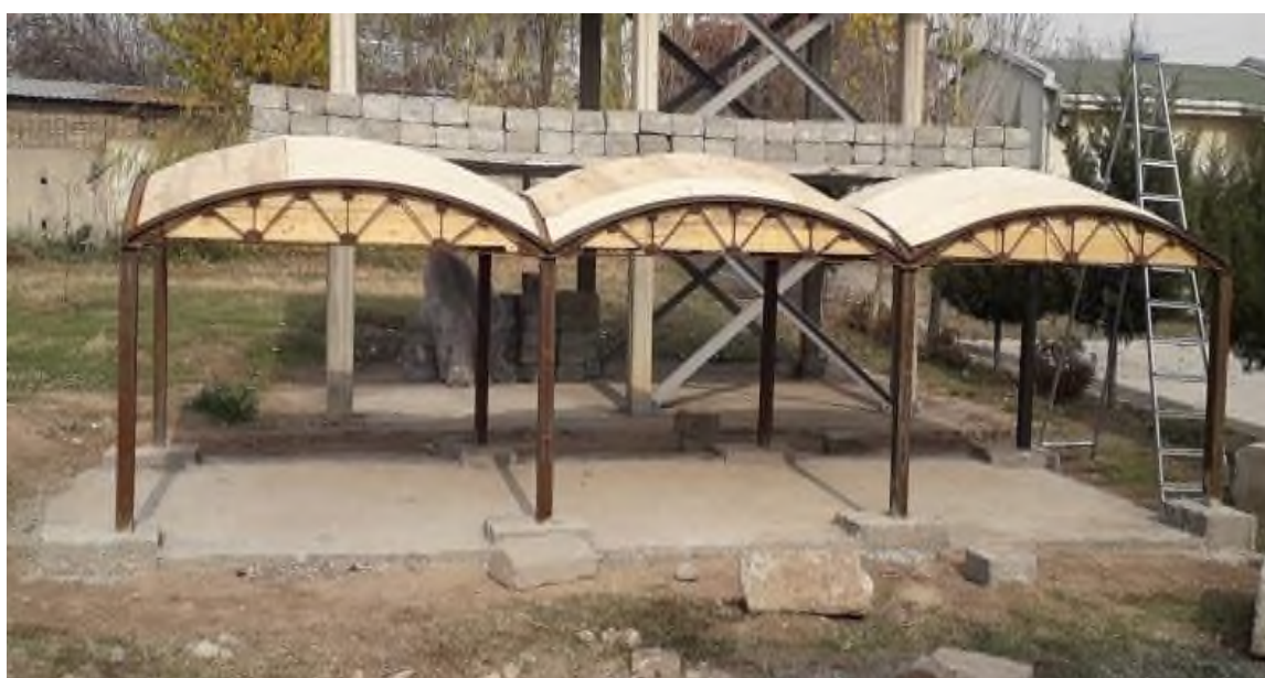
Рисунок 3 – Деревянная опалубка готова к армированию
