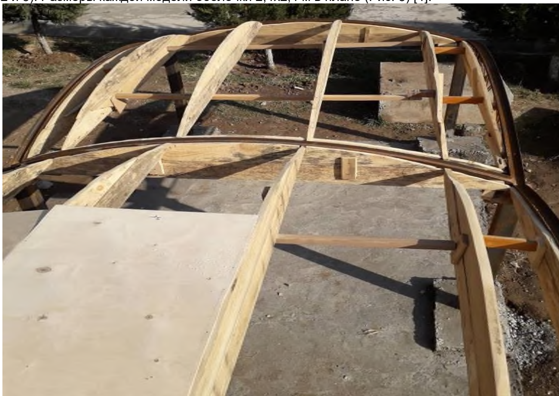
Рисунок 2 – Изготовление деревянной опалубки для армирования
