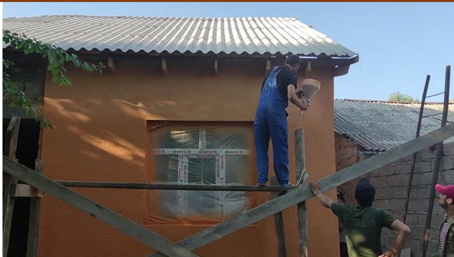
Рисунок 1 - Процесс отделки утепляемой комнаты в пилотном доме, выбранном организацией «ГЕРЕС» [4]
