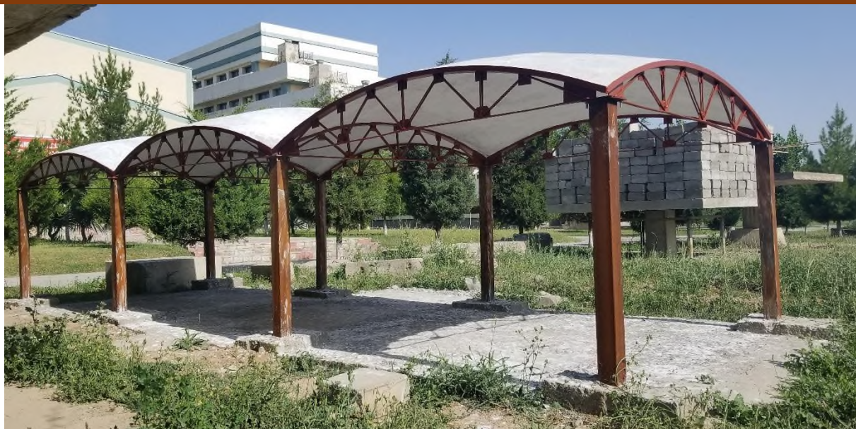
Рисунок 1 – Общий вид МНО-4 на испытательном полигоне кафедры ПГС
